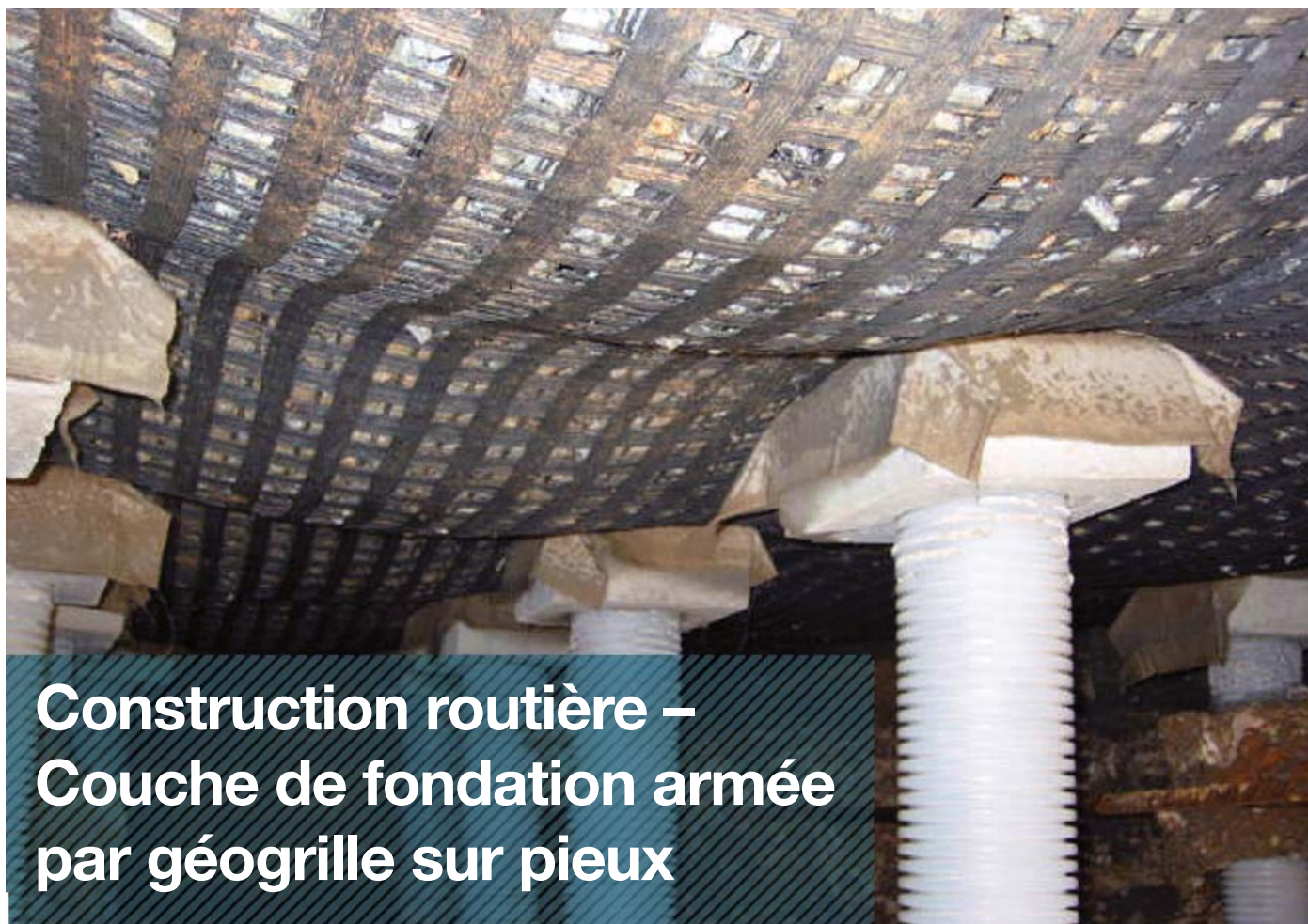
Figure 1: Effet de membrane rendu visible sans contre-pression du sous-sol pour réduire la charge
