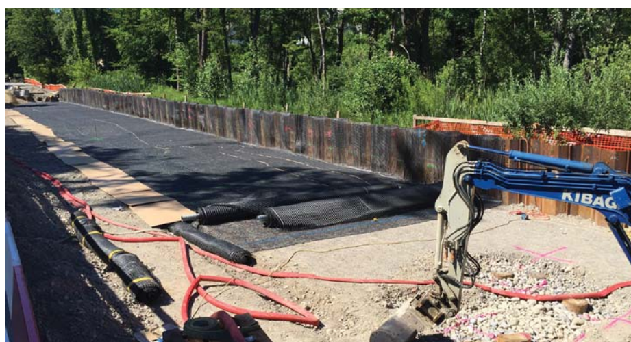
Figure 3: Géo grille Fortrac® posée lors de la 1ère étape de construction.
