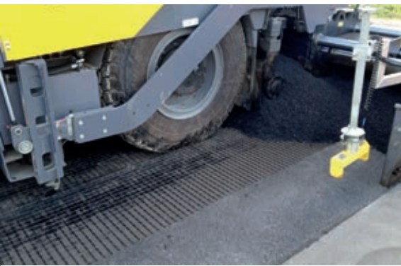
Überbau der HaTelit-Asphaltbewehrung mit einer Asphaltdeckschicht.
