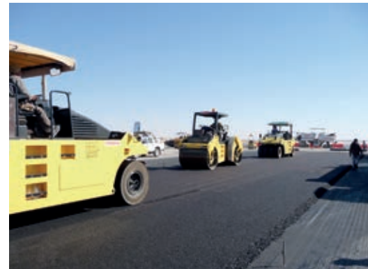
Einflüsse auf die Beschädigung beim Einbau in der Praxis.
