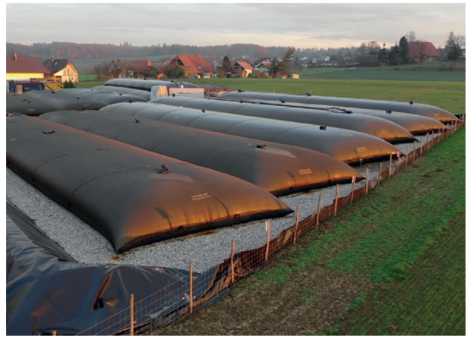
SCHOELLKOPF Dewatering SoilTain – Zum Entwässern von Schlämmen
