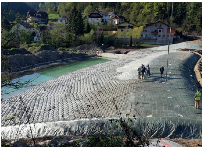
SCHOELLKOPF Schalung Incomat - Betonschalungsmatte für den Wasserbau und den Hochwasserschutz
