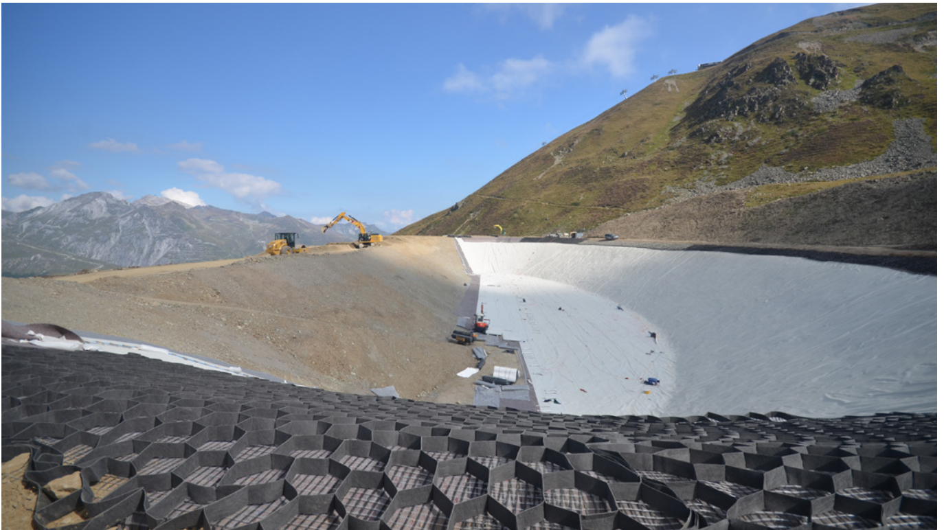
Abbildung: Speichersee Brämabüel, Davos
