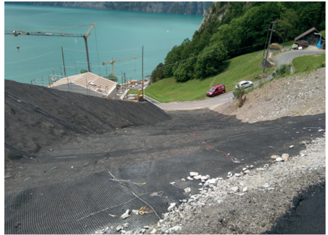
SCHOELLKOPF Geogitter Fortrac 3D – Dreidimensionale Antigleibewehrung
